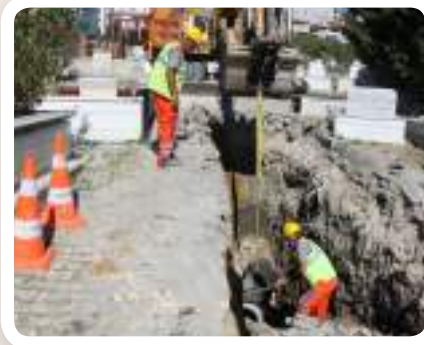
▶ GÜRPINAR MAHALLESİ MEZARLIK İÇİ YAĞMUR SUYU KANAL YAPIMI • FEN İŞLERİ MD.
