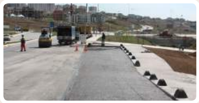
▶ BARIŞ MH. EĞİTİM VADİSİ BULVARI ASFALT YAMA • FEN İŞLERİ MD.
