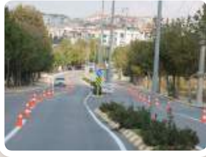
► DEREĞZİ MAHALLESİ SULTAN FATİH CADDESİ YOL ÇİZGİ ÇALIŞMASI • FEN İŞLERİ MD.
