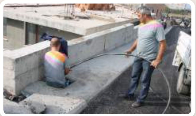
► DEREĞÖZİ MH. EHLİBEYT CAMİİ ETRAFI KABLO DÖŞENMESİ • FEN İŞLERİ MD.
