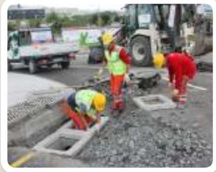
▶ ADNAN KAHVECİ MAHALLESİ SEYRAN SOKAK YAĞMUR SUYU IZGARA YAPIMI • FEN İŞLERİ MD.
