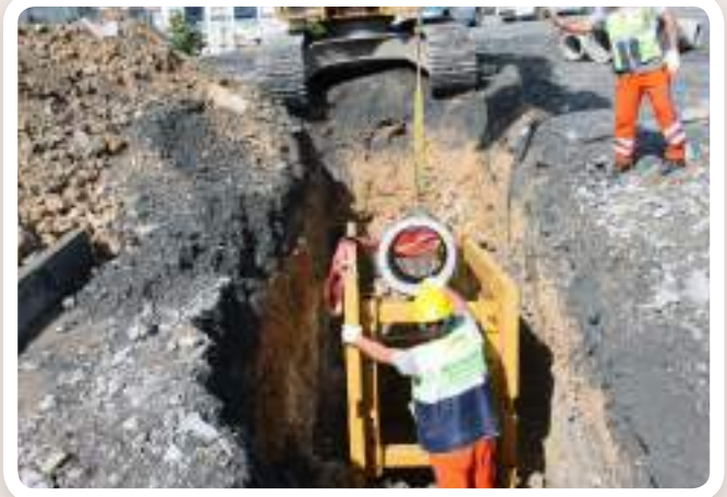
▶ ADNAN KAHVECİ MAHALLESİ SEYRAN SOKAK YAĞMUR SUYU KANAL YAPIMI • FEN İŞLERİ MD.
