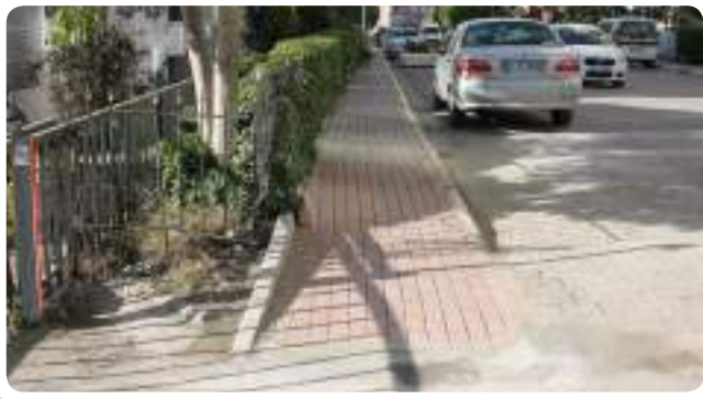
▶ BARIŞ MAHALLESİ NİGAR SOKAK ENGELLİ RAMPASI KALDIRIMLARIN ENGELLİ GEÇİŞLERİNE UYGUN HALE GETİRİLMESİ • FEN İŞLERİ MD.
