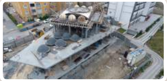
▶ YAKUPLU MAHALLESİ CAMİİ YAPIMI • FEN İŞLERİ MD.
