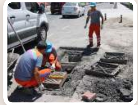
▶ ADNAN KAHVECİ MAHALLESİ DAVUTPAŞA CADDESİ BACA IZGARA YÜKSELTME ÇALIŞMASI • FEN İŞLERİ MD.
