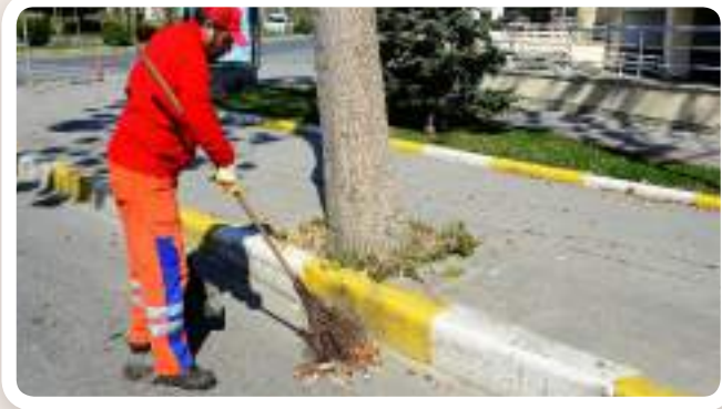
► BETON VE HER NEVİ ASFALT YOLLARIN EL İLE SÜPÜRÜLMESİ • ÇEVRE KORUMA VE KONTROL MD.
