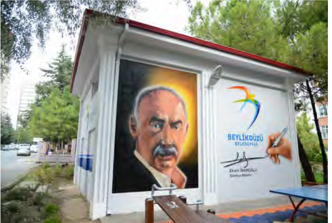
Şener Şen Parkı trafo süsleme
